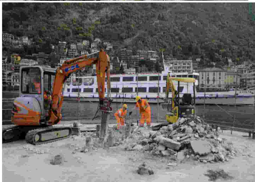
Operai sul tondello. I pali di sicurezza piantati nel fondale del lago sono arrivati a quota 60 metri (fotoservizio Fkd)
